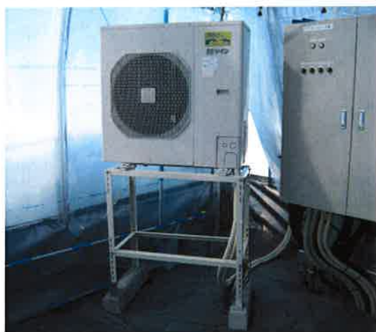
ハウス栽培に導入したヒートポンプシステムの室内機(株式会社イース)
